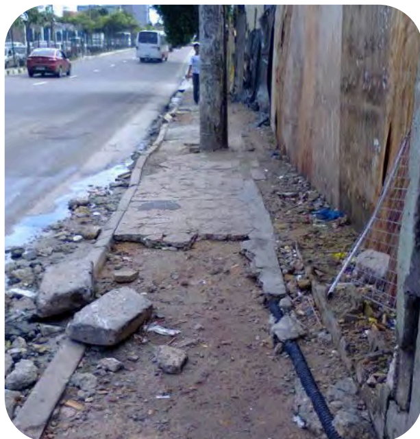
Avenida Djalma Batista | Fonte: arquivo do autor.
